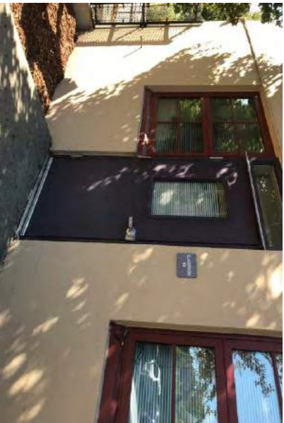
#9 STEEL EXTERIOR DOOR
