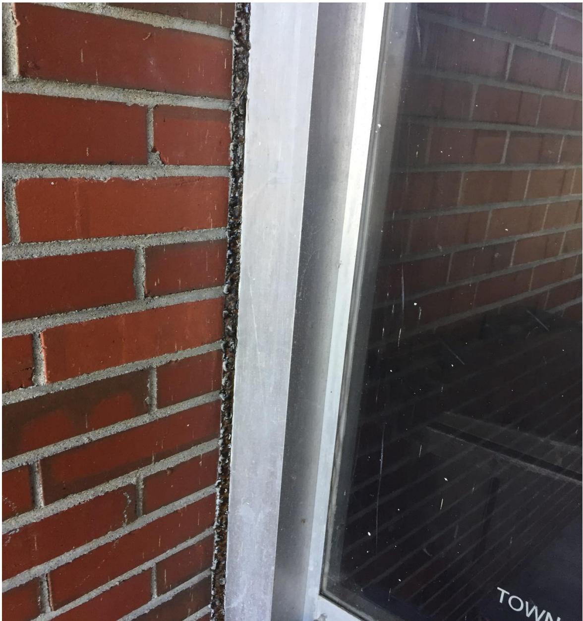
ACM Door Caulk
