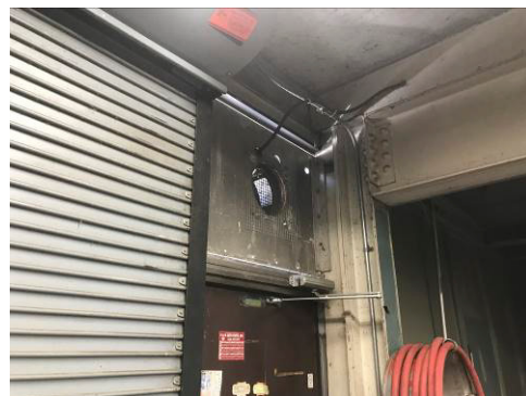
Wall Propeller Fan
