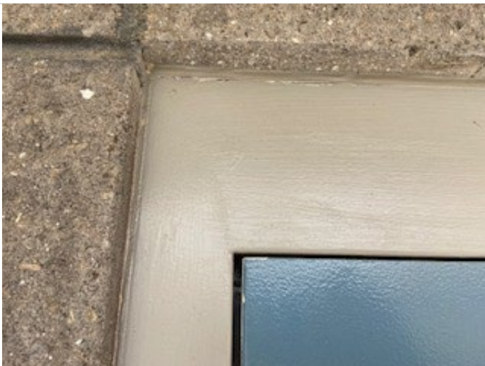
Tan Paint on Metal Door Frame
